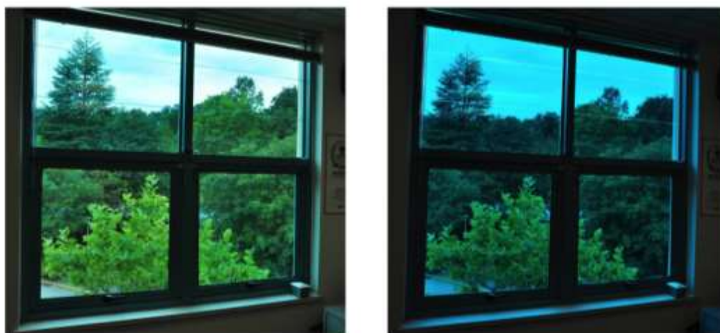
图 19 智能玻璃技术的例子。右：更加透明，左：不透明 (Albright, p.17)
