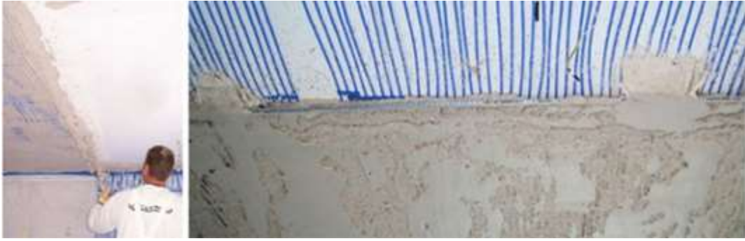
图22 安装含 PCM 增强石膏和塑料微管主动冷冻天花板系统。Fraunhofer ISE, 德国
