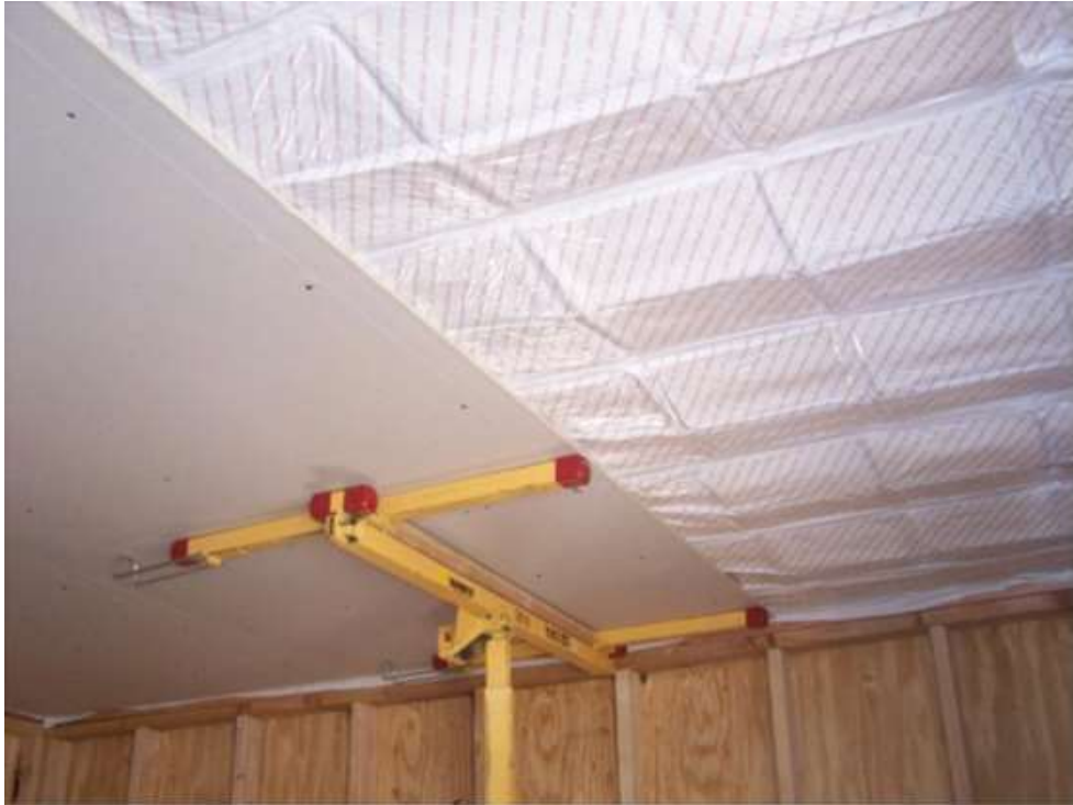
图 26 安装生物 PCM 垫在天花板上( Muruganantham, 2010, p.16)
